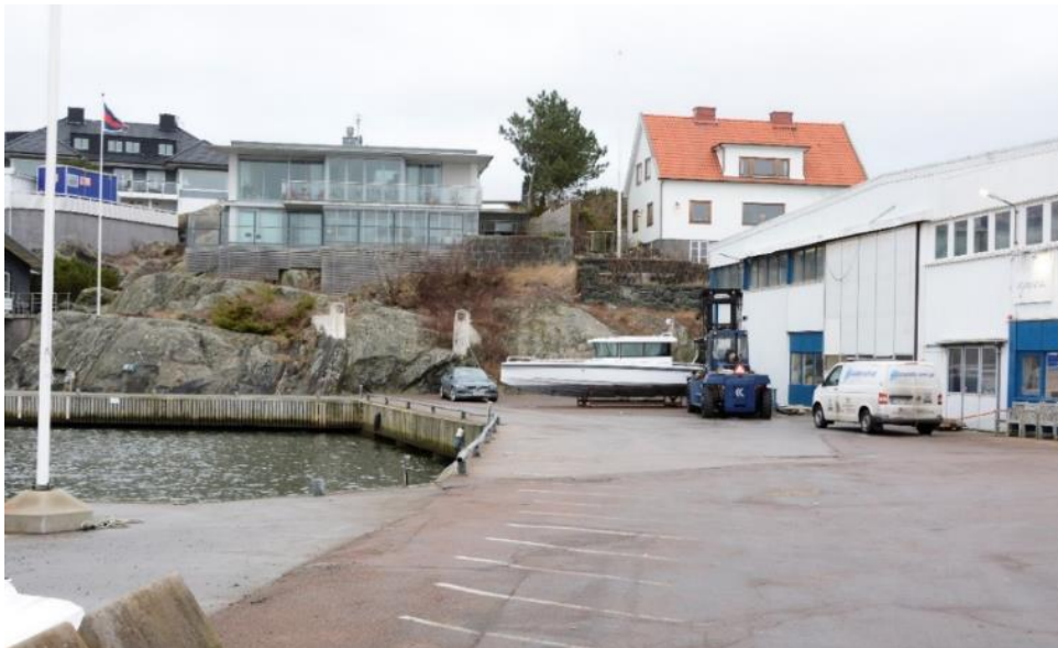
Figur 10. Befintlig bebyggelse inom planområdet till höger i bild med angränsande villabebyggelse i bakgrunden.
